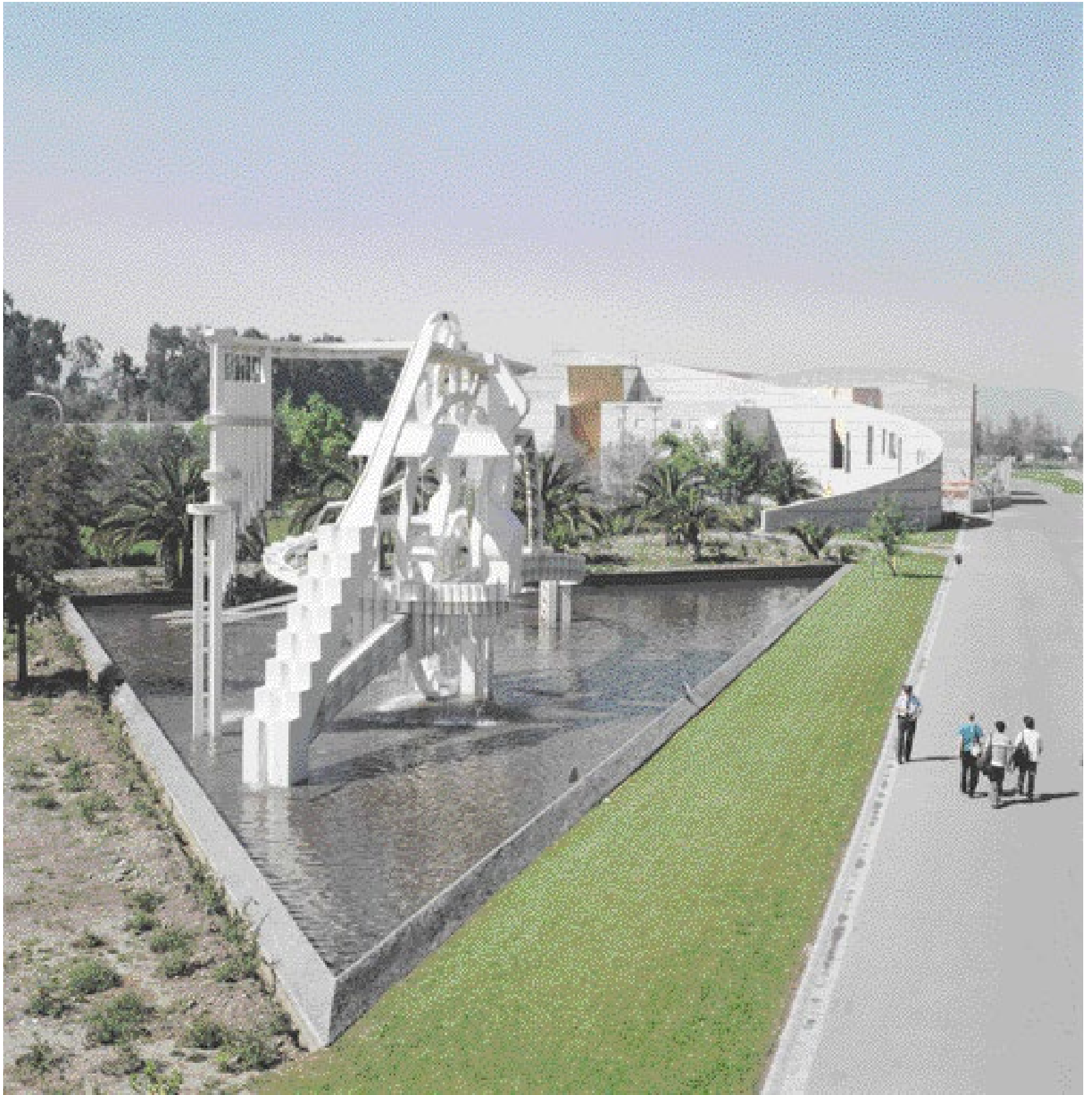
Rueda de Larmahue Museo Interactivo Mirador, Santiago, Chile - 1998-2000 Acero forjado y soldado (carpintería metálica) - 48 x 12.5 x 15 mts. Vista desde el Norte
