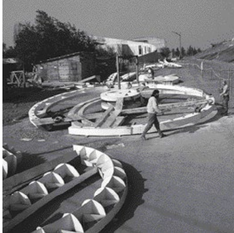
Armado vigas y rueda
